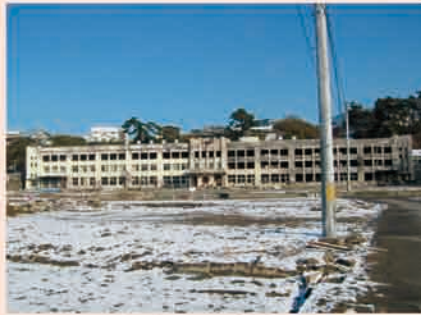
津波と火災被害の小学校
