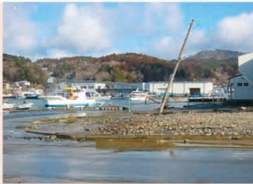
地盤沈下した鮎川浜
