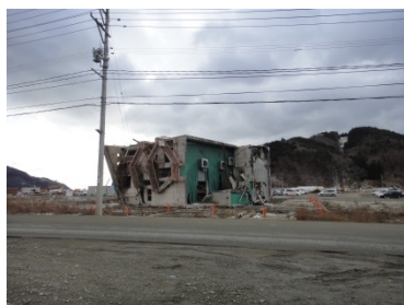
女川町ビル倒壊状況
